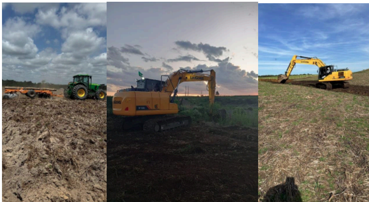
Figura 13 - Grade pesada 16x34; Escavadeira 915E; Escavadeira 922E
