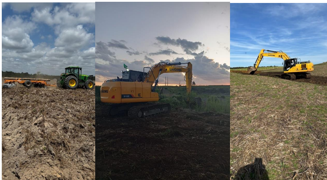
Figura 13 - Grade pesada 16x34; Escavadeira 915E; Escavadeira 922E
